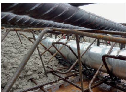
Positionnement des tubes contrôlé à tout moment
