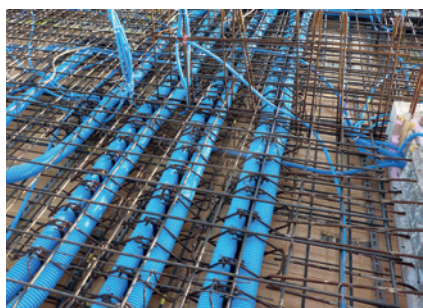
Renforcement avec économie de place grâce à l'introduction de deux tubes par élément
