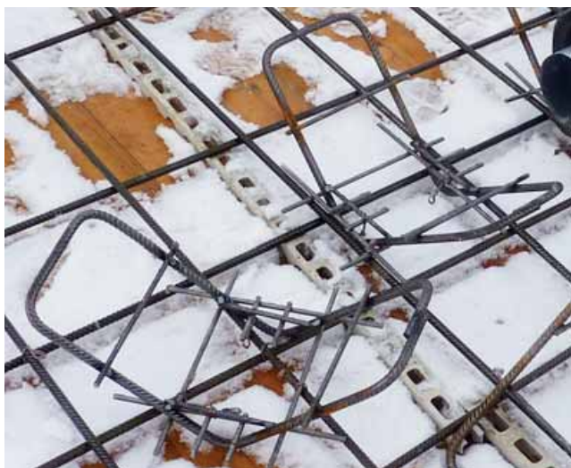
Fuss BASYTUBE V G-150-F während Einbau Leitungen
