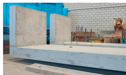
Comportements très différents pour des balcons parfaitement identiques en raison des différentes rigidités des dalles.
